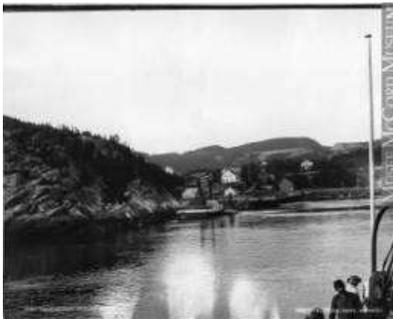
La mise en place de la cale sèche Imbeau à Tadoussac en 1932 constitue un bel exemple d'ingéniosité et d'économie de moyens de la part de son concepteur. Mettant à profit les avantages naturels d'une petite baie aux parois rocheuses abruptes, les portes sont fixées directement dans la pierre, à l'endroit où l'entrée forme un étranglement. Puis c'est la marée qui fait le travail. Une fois les navires échoués à l'intérieur de la baie, il n'y a plus qu'à fermer les portes, et le
